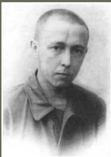
Солженицын на строительстве дома у Калужской заставы. Москва. 1946 г.
